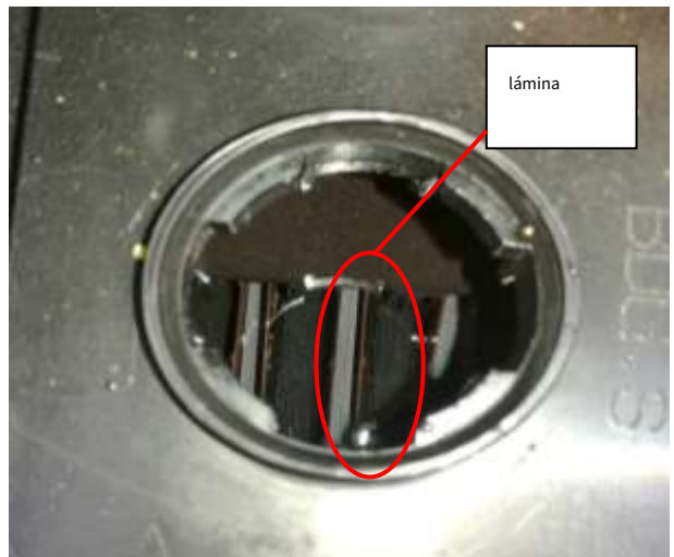
4. No se puede ver la barra colectora en algunos modelos. El nivel del líquido está 10 mm más abajo que la placa, luego agregue agua destilada
