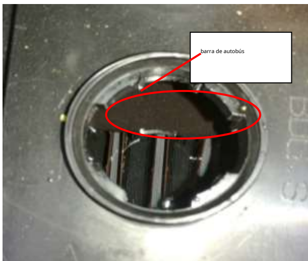
3. El nivel de electrolitos está más bajo que la barra colectora, entonces agregue agua destilada.
